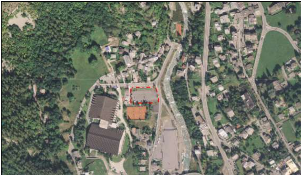
Figura 1: Ortofoto dell'area di intervento (estratto da http://geonavsct.partout.it/ ). Il rettangolo indica l'areale oggetto di studio.
